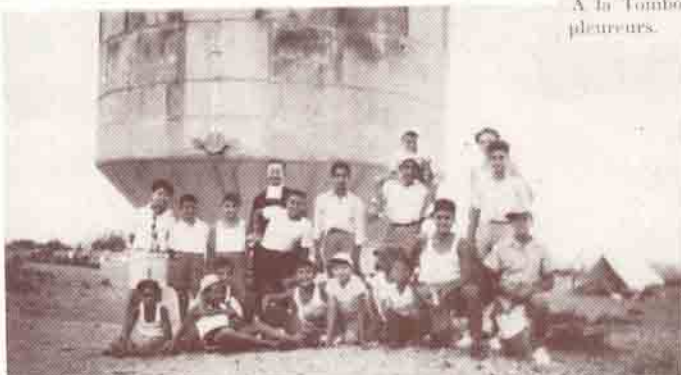
Au pied du réservoir — Rosette.
